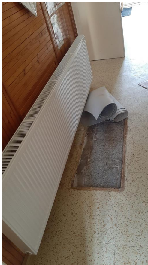
Díra v podlaze po starých akumulacích kamnech a již nový radiátor.
